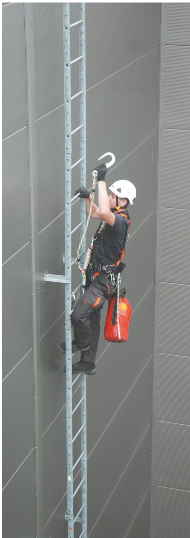
Sposoby dostępu - po drabinie: szelki, amortyzator bezpieczeństwa z dwiema linkami.
