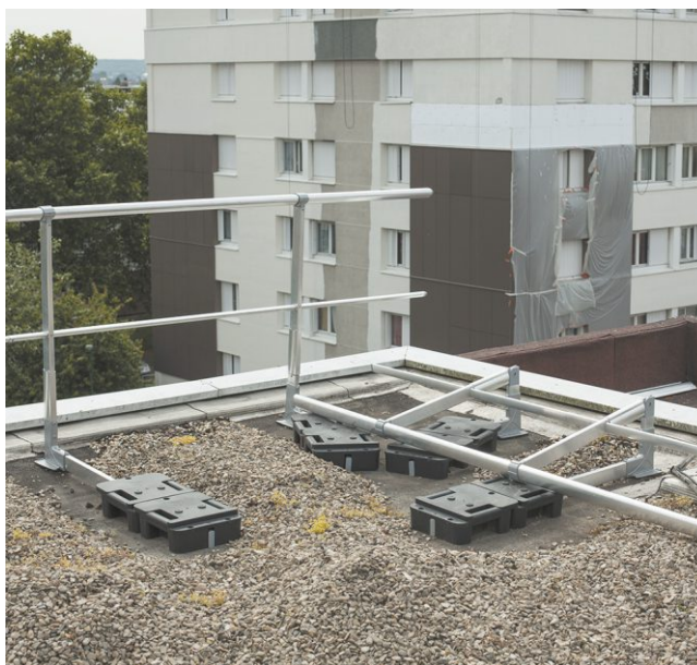
Balustrada wolnostojąca kładziona
