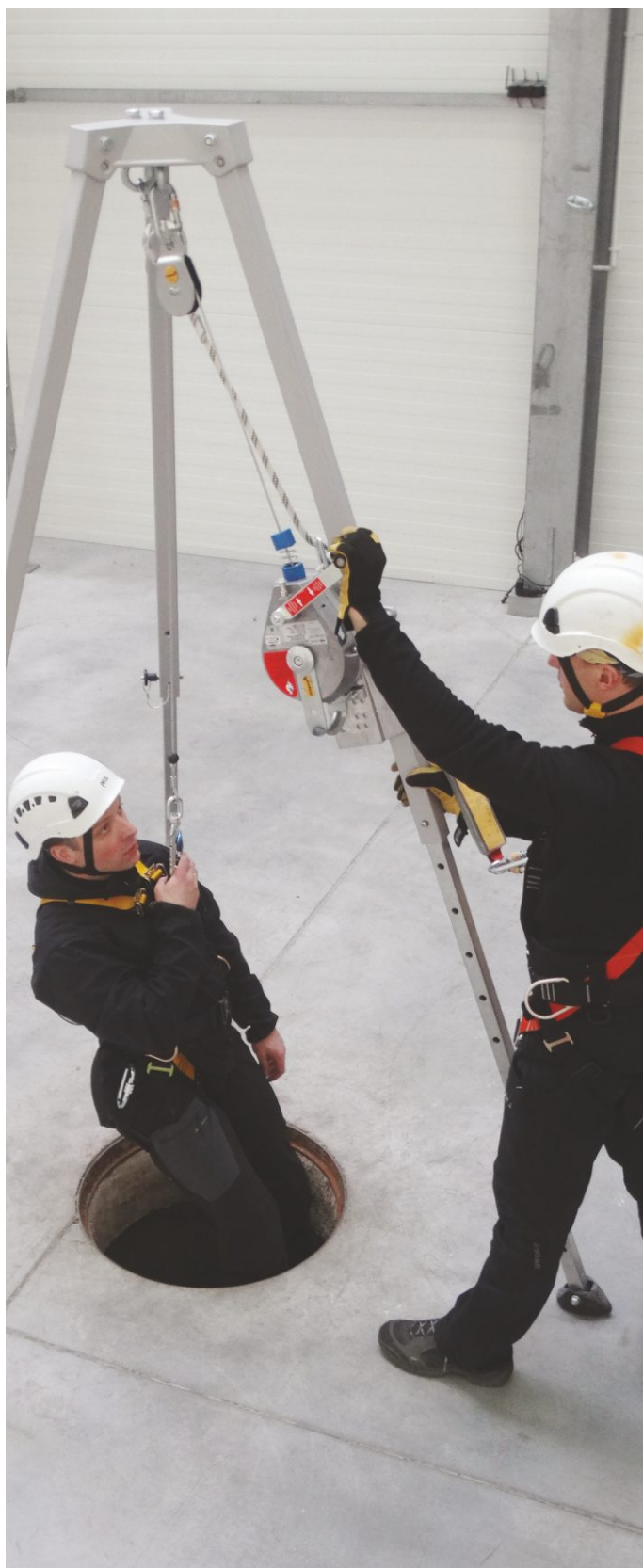
Praca i ewakuacja z zagłębienia: szelki, trójnóg ratowniczy, urządzenie samohamowne z wciągarką korbową.
