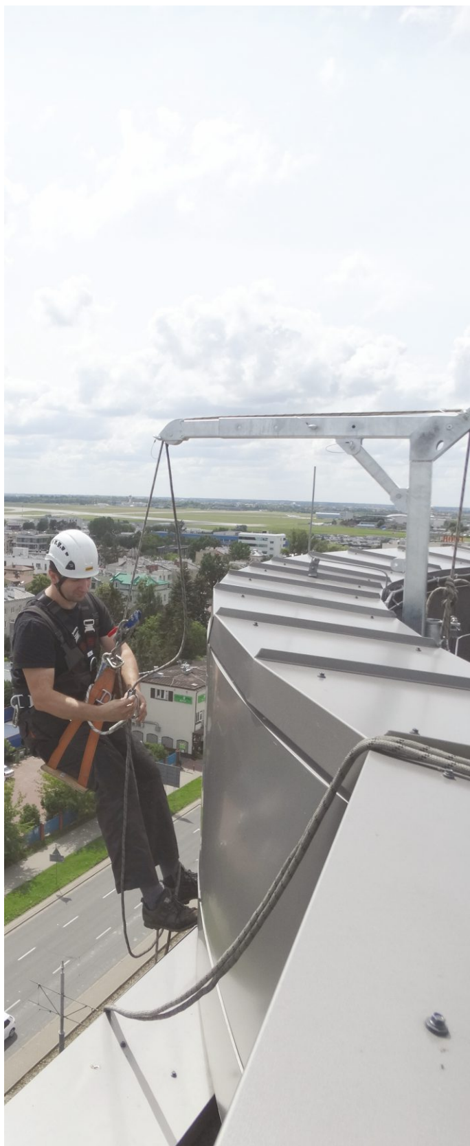
Prace w dostępie linowym przy elewacji: żurawik PTA, szelki, urządzenie zjazdowe na linie roboczej, urządzenie samozaciskowe na linie asekuracyjnej.
