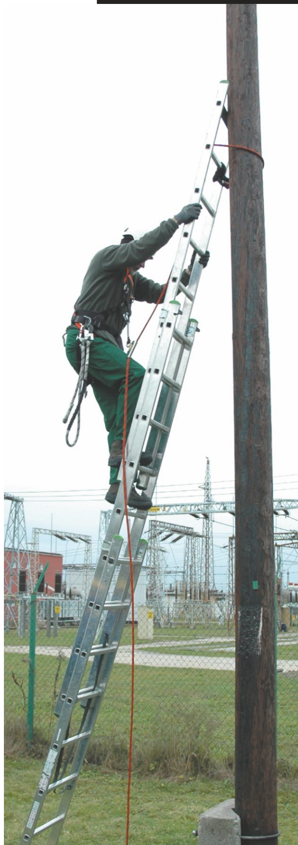
Sposoby dostępu - po drabinie przystawnej: szelki, linka opasująca, lina i urządzenie samozaciskowe.
