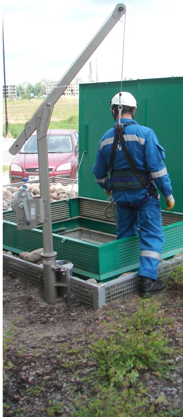
Praca w zagłębieniu: szelki, żurawik obrotowy, urządzenie samohamowne z wciągarką korbową.
