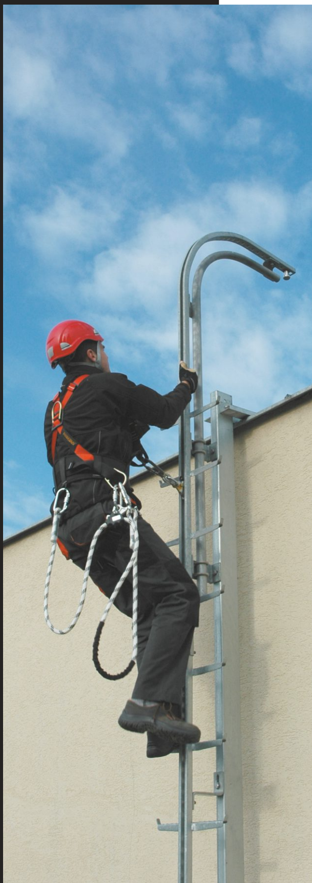
Sposoby dostępu - po szynodrabinie: szelki, linka opasującą, szynodrabina z łukiem wyjściowym i wózek asekuracyjny.
